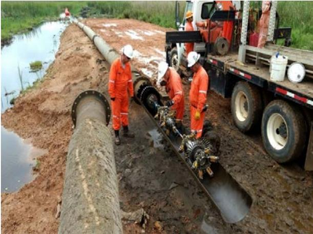
图3 PA12内衬修复管道施工现场
