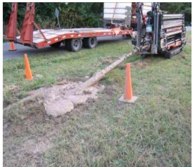
图 2 PA12 管道 HDD 施工现场
